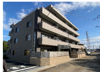
移転先に竣工した建物の全景
