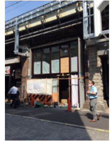
▲新築中の神田珈琲園 まもなく竣工です
