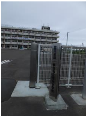
震災遺構となった荒浜小学校
