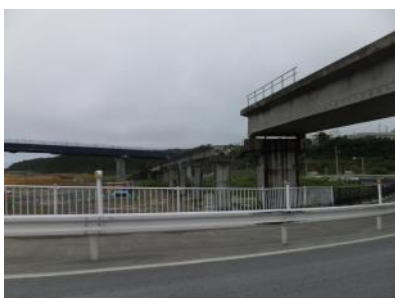
気仙沼の防潮堤と被災した鉄道
