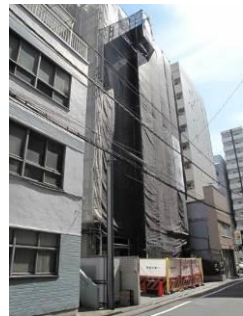
現在のCOMS HOUSE シート養生中
