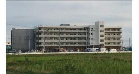
あおい地区最新情報！(5階建ての災害公営住宅)
