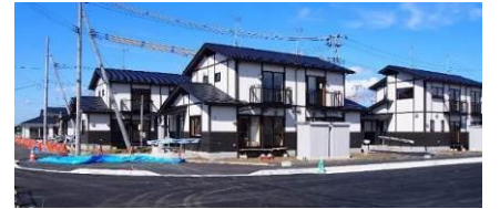
災害公営住宅第Ⅰ期エリアの様子
