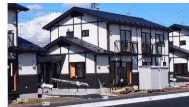
災害公営住宅(近景)
