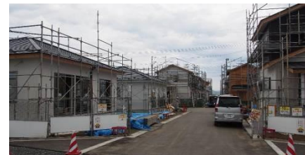
あおい地区：災害公営住宅建設の様子
