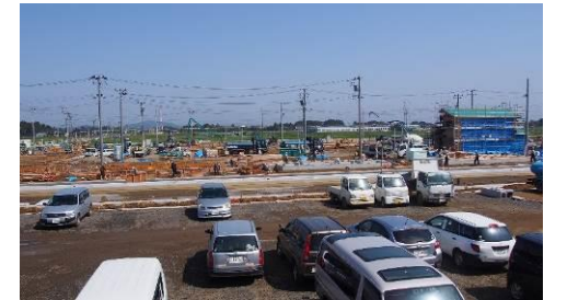
本格的に建築工事が動き出した災害公営住宅第Ⅰ期(5月28日現在)
