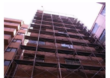
組上がった足場
