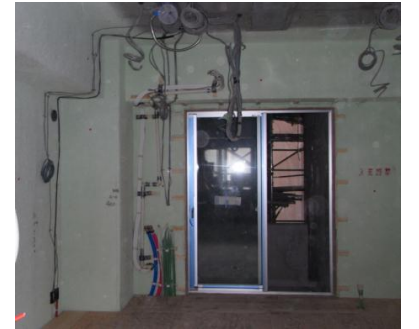
躯体内部の様子
