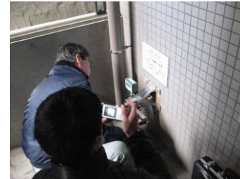
専用の計測器で外壁タイルの引張強度(付着力)試験
