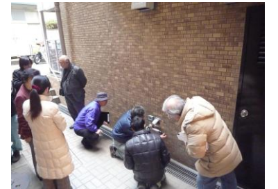
タイルの付着力検査をしています
