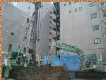
奥澤：現場の様子
